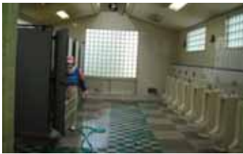
図3 改修前の湿式清掃
